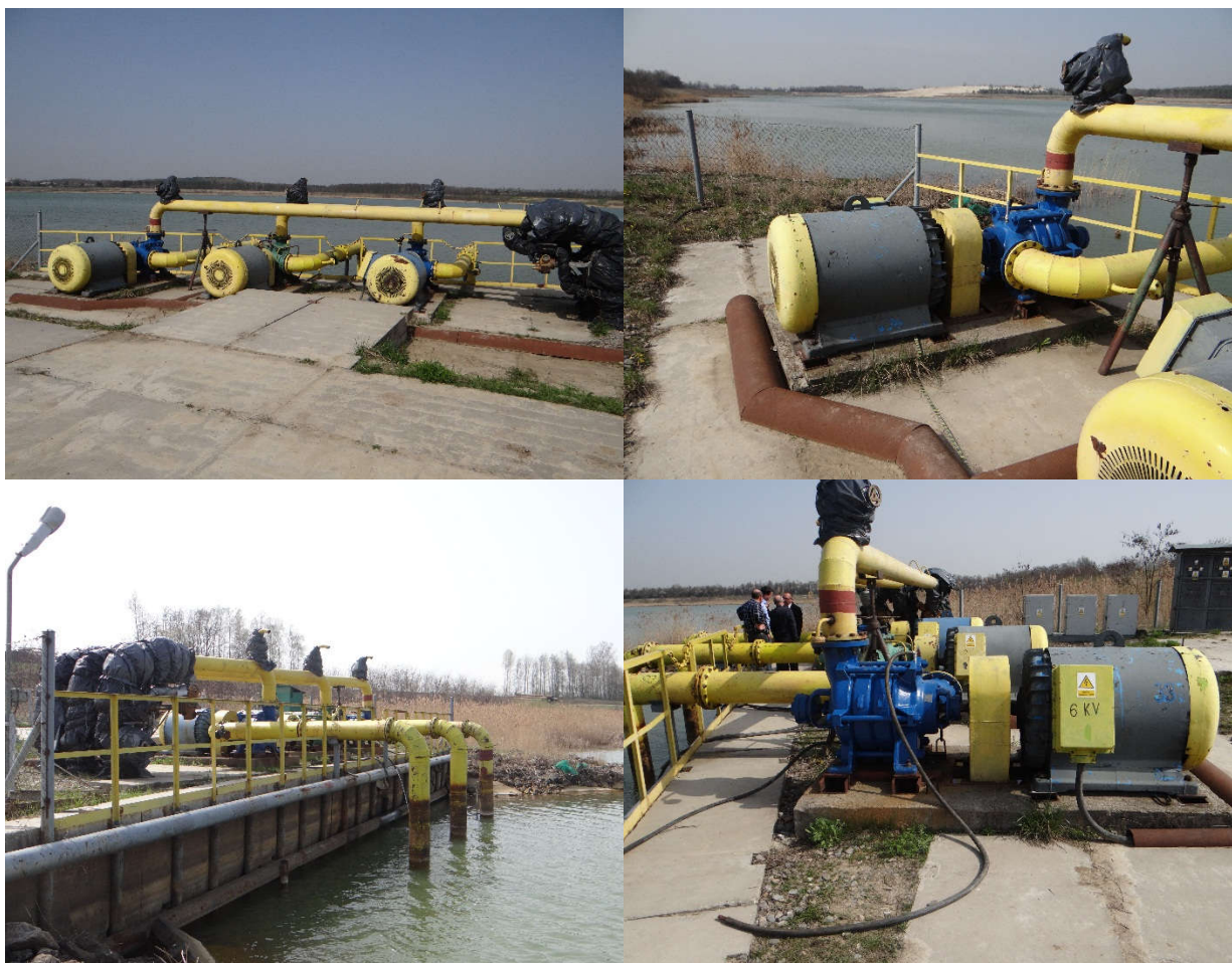
ZDJĘCIE 1 – STANOWISKO POMPOWE – STAN ISTNIEJĄCY
